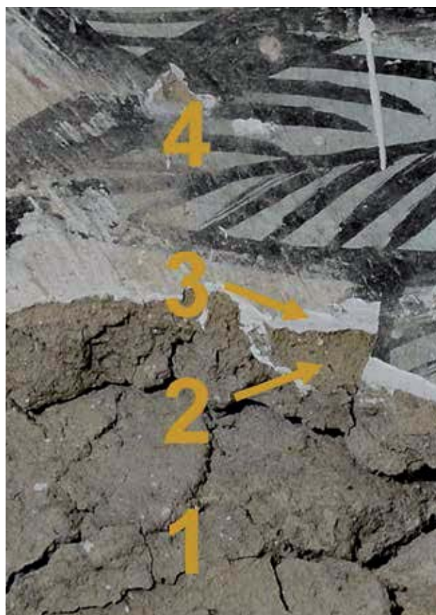
Figura 1. Secuencia de las técnicas del mural: enfoscado (1), enlucido (2), enlucido final de yeso (3) y pintura (4). (Carlos Nodal)
