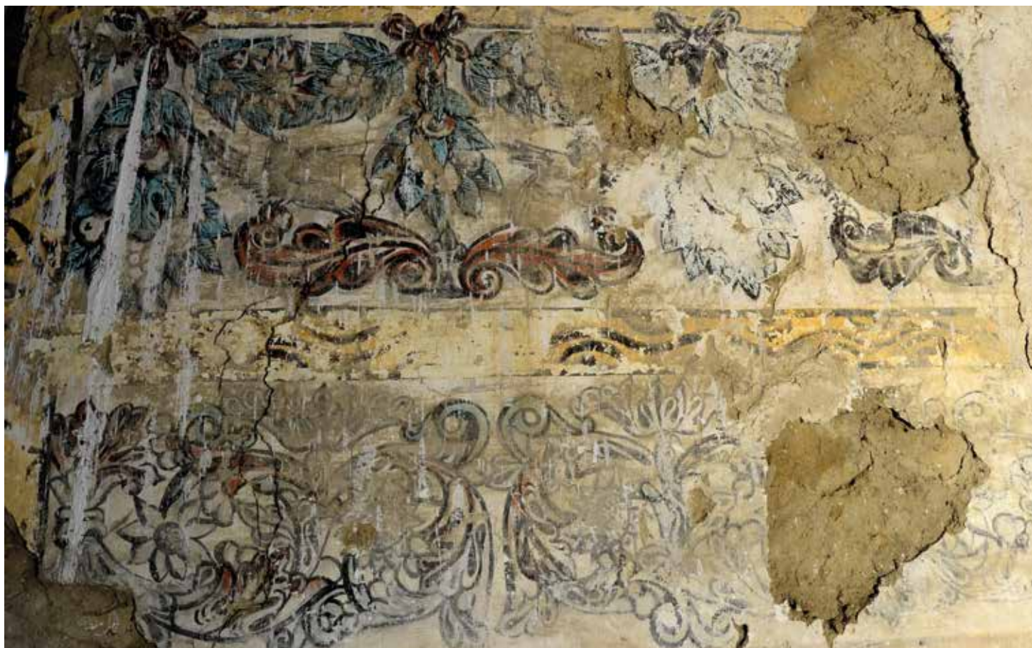
Figura 6. Pormenor de las diversas patologías, con lagunas producidas por el desprendimiento de enlucidos, dejando el enfoscado a la vista. (Carlos Nodal)
