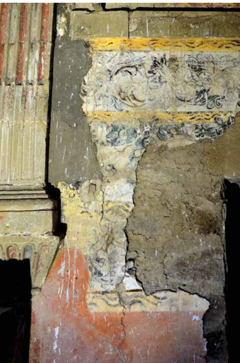
Figura 3. Desprendimientos de pintura afectando a los revocos, algunos rellenados con cemento portland (Carlos Nodal)
