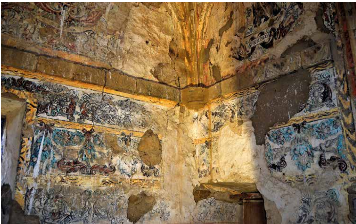
Figura 7. Aspecto general: desprendimientos de revocos, rellenos de cemento, suciedad, etc. (Carlos Nodal)
