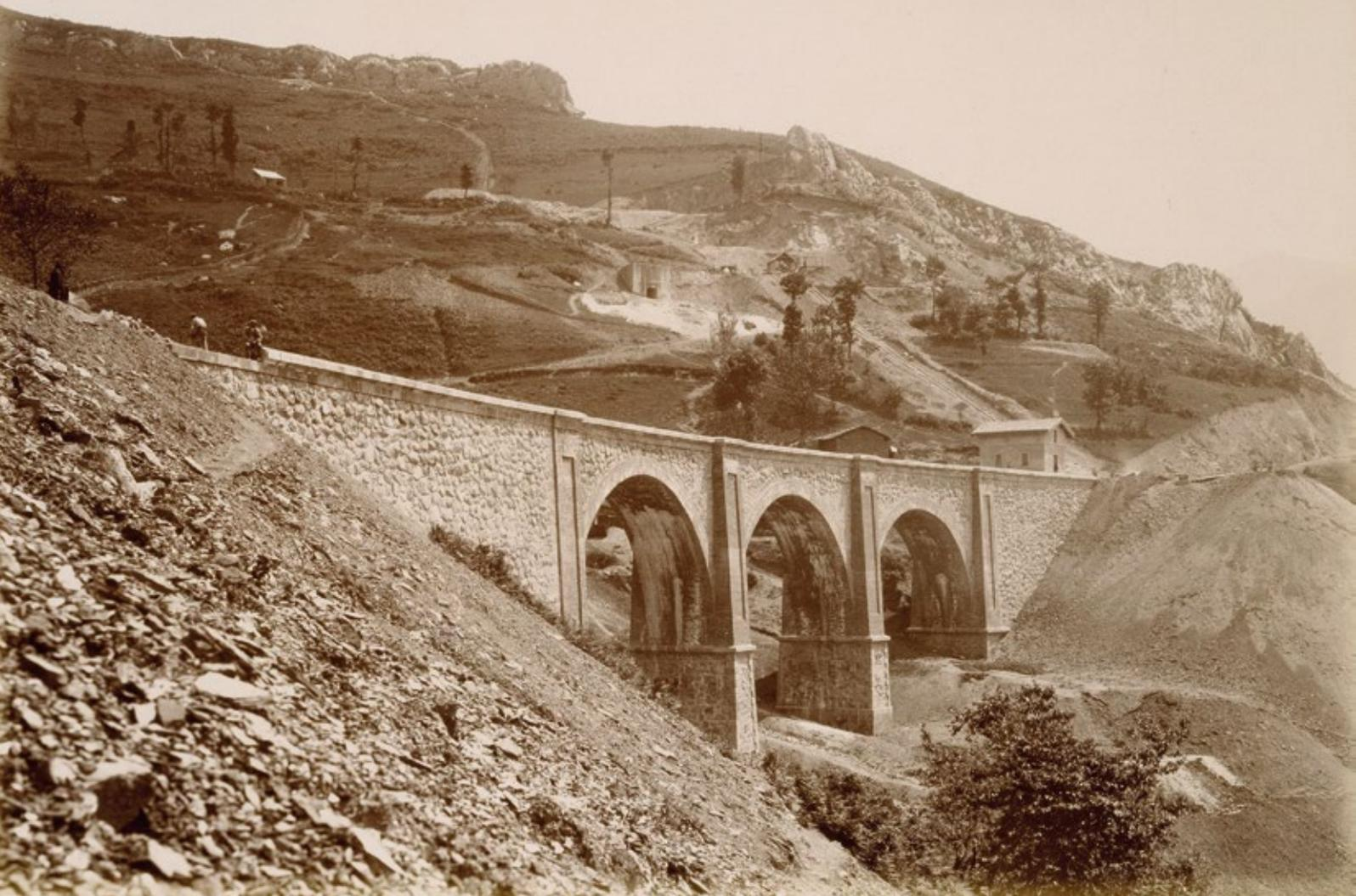
**Figura 2.** El proyecto del ferrocarril de Pajares exigió una gran cantidad de obras de fábrica de importancia, entre ellas numerosos puentes y viaductos como el de Burón, que vemos en sus últimas fases de construcción en esta fotografía de Sauvanoud, tomada en 1884. (*Biblioteca Nacional*).
