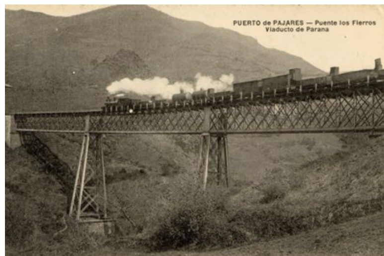
Figura 11. La principal obra de fábrica de Pajares, el viaducto de Parana, sostiene un tren ascendente de mercancías remolcado por una «verraco». Este espectacular puente fue proyectado en los talleres de Eiffel y es una de sus obras más atrevidas, a la par que más desconocidas a nivel internacional. Colocado en curva de 300 metros y rampa de 20 milésimas, sobrevivió en servicio hasta los años posteriores a la Guerra Civil, cuando fue sustituido por un pedraplén para permitir el paso de nuevas locomotoras eléctricas más pesadas. Sus pilares de celosía aún permanecen allí enterrados. (Postal comercial, original de la colección del Museo del Ferrocarril de Asturias, reg. P.3.4.174)
