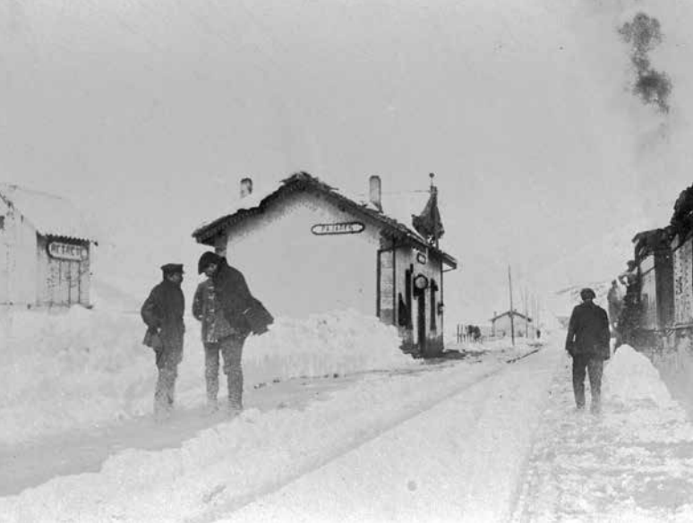
Figura 15. La estación de Pajares entre la nieve. Las dos locomotoras de vapor a la derecha de la imagen están unidas por sus tenderes, lo que demuestra que se trata de «exploradoras», es decir máquinas que, en días de nevada, recorrían continuamente las vías del puerto para intentar mantenerlas despejadas. H. 1915. (Original de la colección del Museo del Ferrocarril de Asturias, reg. 15.38)
