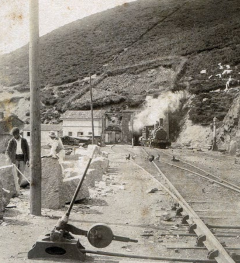
Figura 13. Un tren de mercancías entra en la estación de Navidiello, tras salir penosamente del túnel del mismo nombre. Los sillares corresponden a los trabajos de ampliación de la longitud de las vías de la estación, que requirieron excavar un túnel gemelo a «La Polea». La aguada, el gálibo de carga para proteger los túneles y las «pitas» del personal de la estación, completan la escena. (Original de la colección del Museo del Ferrocarril de Asturias, reg. P.37.7.4968)
