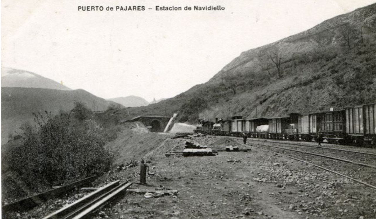
Figura 12. A pesar de la leyenda de la postal, se trata en realidad de la estación de Linares donde un variopinto mercancías espera un cruce. Lo encabezan dos «verracos», una de ellas sin duda de retorno, probablemente de dar una doble tracción. En primer plano material de vía usado en los continuos trabajos de mantenimiento que el trazado del puerto ha exigido desde su apertura. (Postal comercial, original de la colección del Museo del Ferrocarril de Asturias, reg. P.3.1.163)
